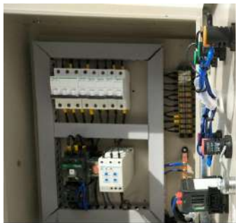
Gambar 27. Kontrol panel tampak luar dan dalam
